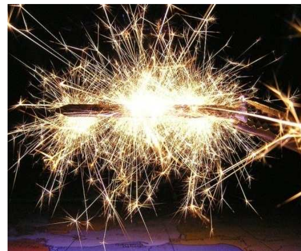
Court-circuit en très basse tension 12V/20A
